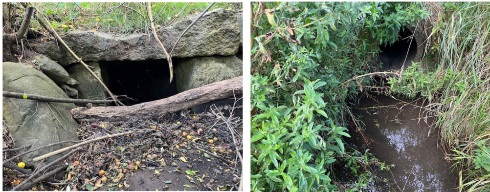
Billeder af hhv indløb (til venstre) og udløb (til højre) af rørlægning AAL-1180_a.
