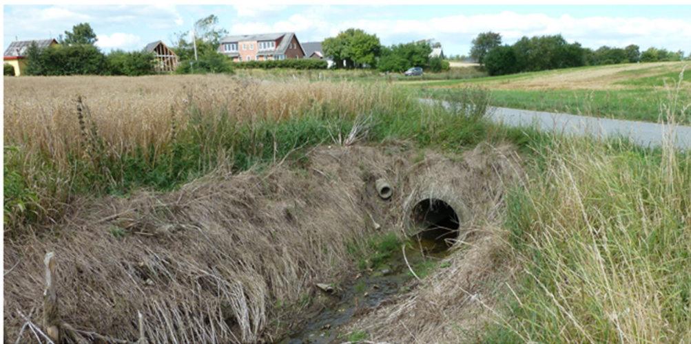
Billede af udløb, rørlægning AAL-1180_c.
